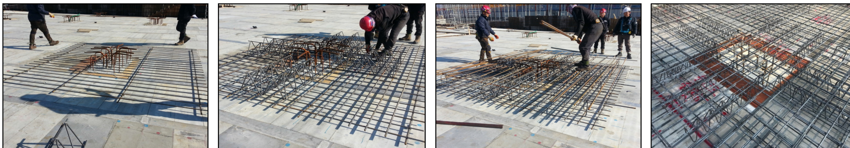
Install Solid TrussStud
